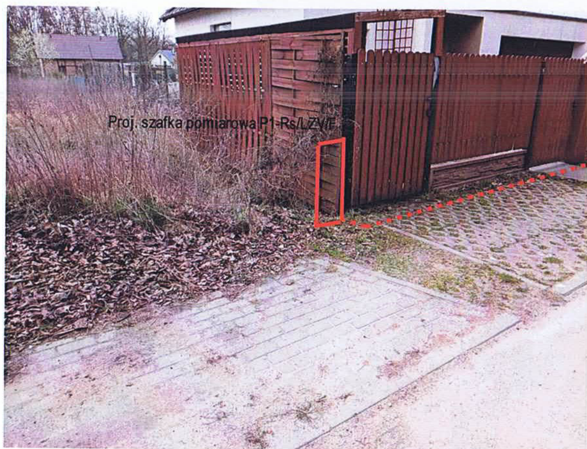
Trasa przyłącza kablowego nN wraz z lokalizacją szafki pomiarowej
